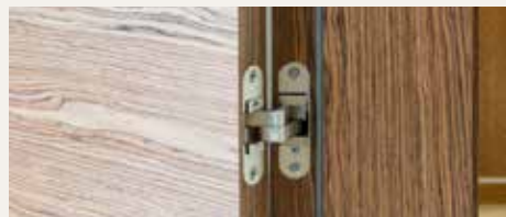
A falc nélküli ajtó esetében az ajtólap nem a tokra záródik. Azzal, hogy az ajtólap belezáródik a tokba, újszerű megjelenést ad az ajtónak, hiszen így az ajtólap és a tok szerkezet egy síkot képez (open-doors.hu)
